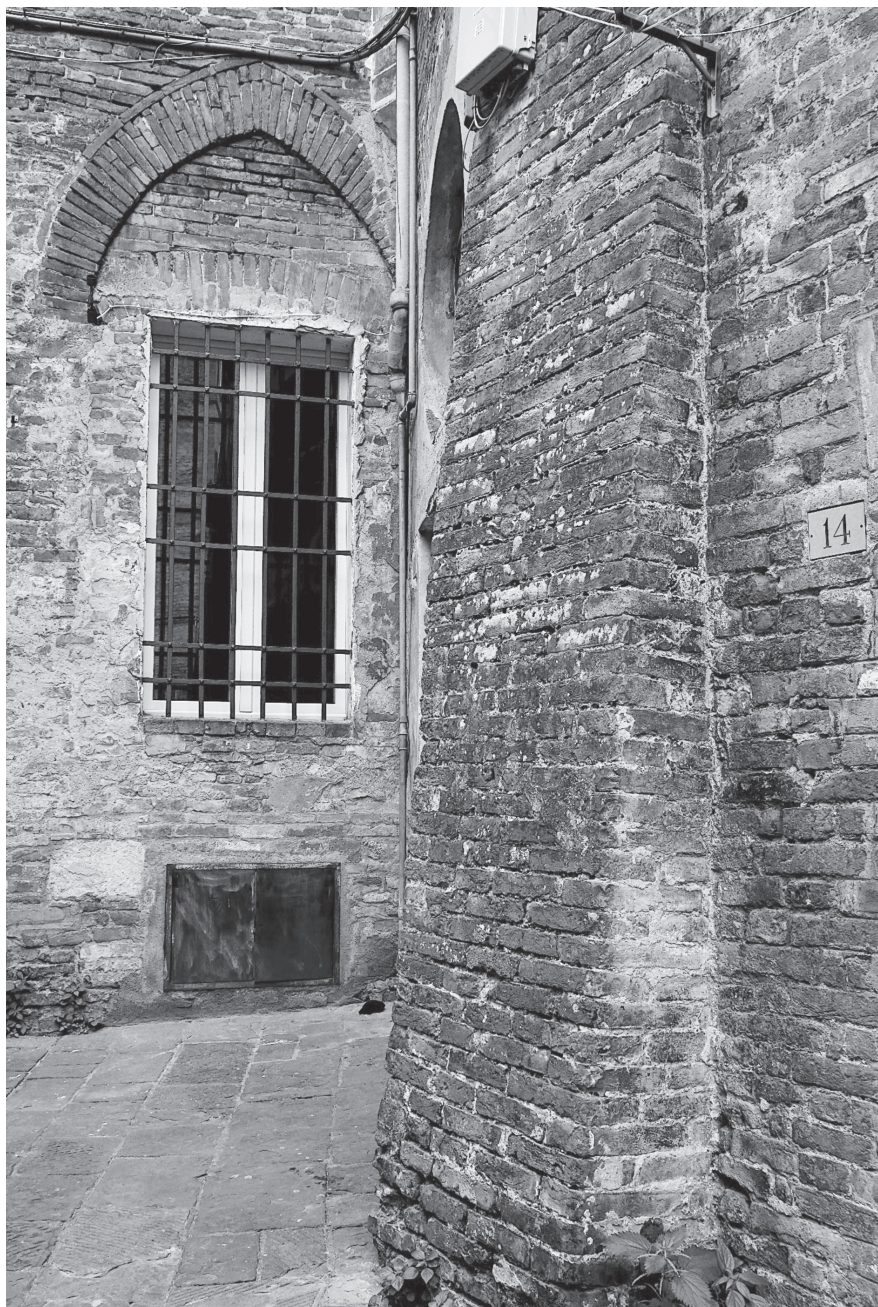
Fig. 3 – Un esempio di contrafforte utilizzato nel centro storico di Siena.
