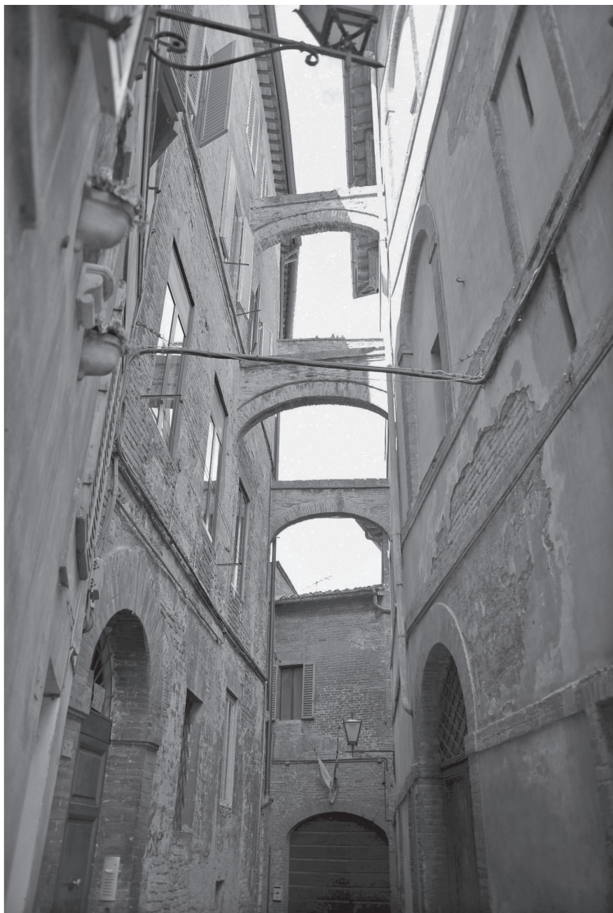
Fig. 2 – Alcuni esempi di archi di contrasto utilizzati nel centro storico di Siena.
